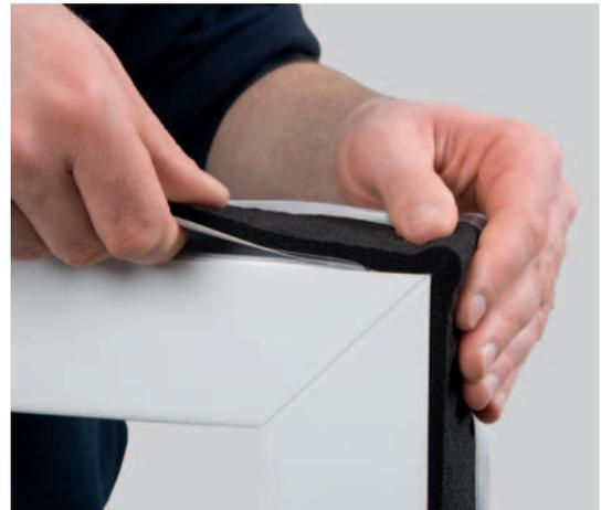
\* Bauteilbewegung und temporäre Längenänderungen der vorhandenen Fugen sind bei der Ermittlung der geeigneten Banddimension zu berücksichtigen.
